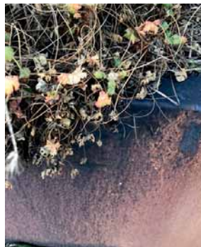
Schwarze Verfärbungen auf der Cortenstahl-Oberfläche durch organische Elemente.
