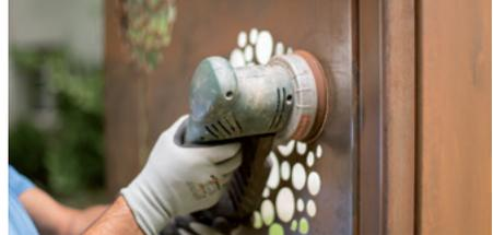
*Schritt 1: Die vorhandene, grobe Rostschicht entweder mit der rauen Seite eines Küchenschwamms oder grobem Schleifpapier entfernen bzw. anschleifen.*
