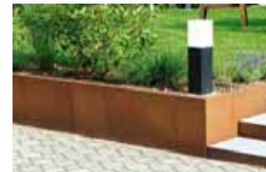
... Elemente daher im Bodenbereich 3-10 cm länger planen.
