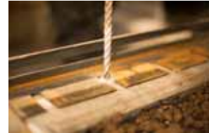
Bohren für Dübelbefestigung
