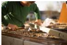
Ebenheit mit langer Wasserwaage prüfen
